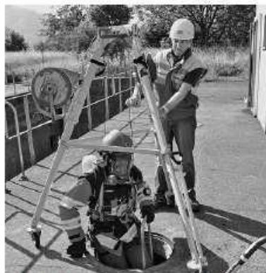
Bild 1: Beim Einsteigen in einen Schacht ist Alleinarbeit verboten. Denn im Notfall (Ersticken) ist sofortige Hilfe nötig. Die einsteigende Person muss dauernd von einer zweiten Person überwacht werden (Richtlinie 1418.d).
