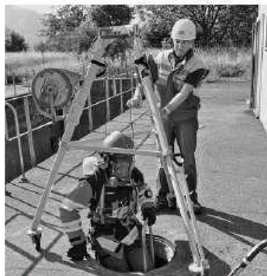
Bild 1: Beim Einsteigen in einen Schacht ist Alleinarbeit verboten. Denn im Notfall (Erstikungsgefahr!) ist sofortige Hilfe nötig. Die einsteigende Person muss dauernd von einer zweiten Person überwacht werden (Richtlinie 1418.d).
