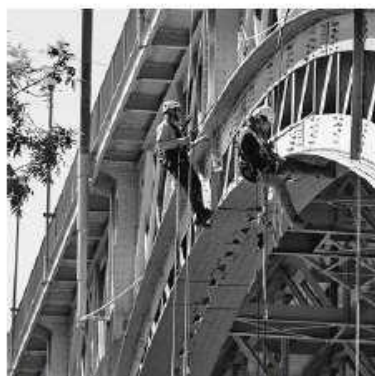
Bild 3: Arbeiten am hängenden Seil dürfen nur in Sichtverbindung und Rufweite einer zweiten Person ausgeführt werden (Bauarbeitenverordnung, Artikel 82).
